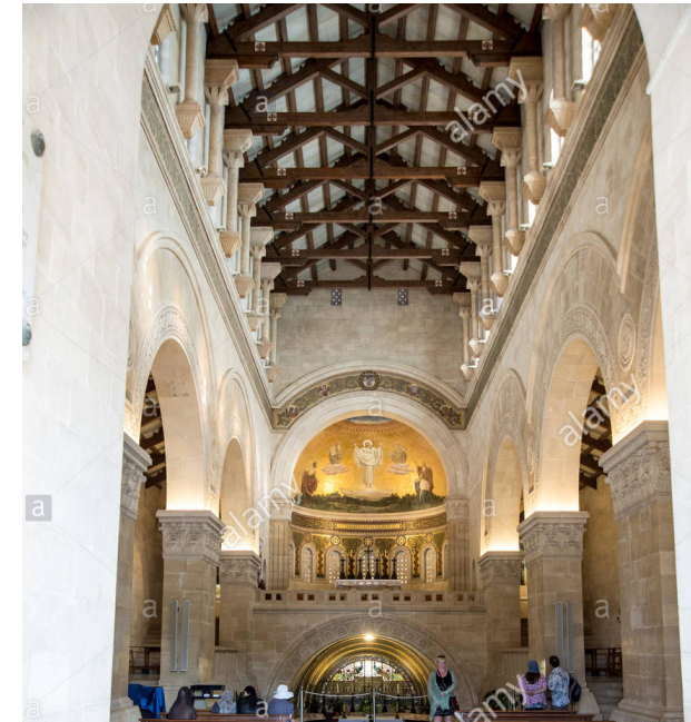
Cubierta con vigas vistas de madera
